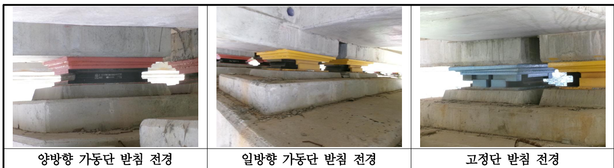
【사진 25.3.12】 교량받침 전경
