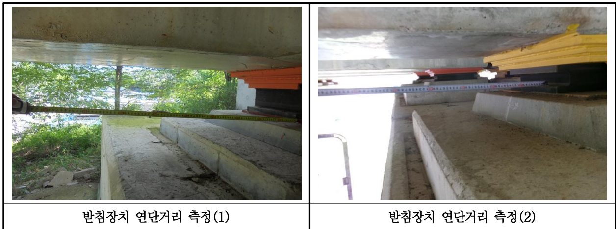
【사진 25.3.14】 교량받침장치 연단거리측정
