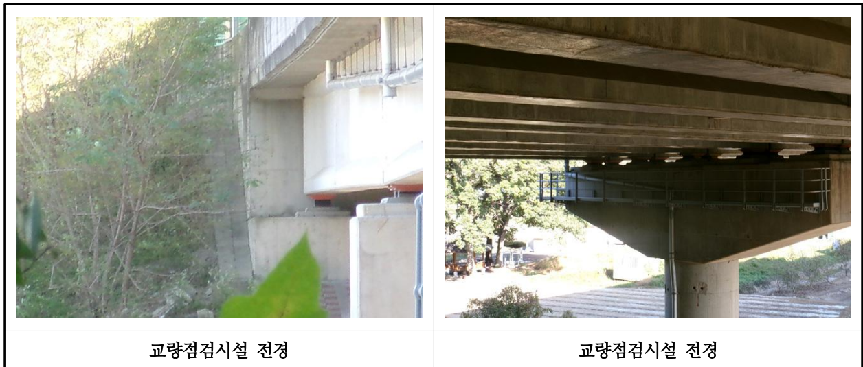
【사진 25.3.25】 교량 점검시설 전경
