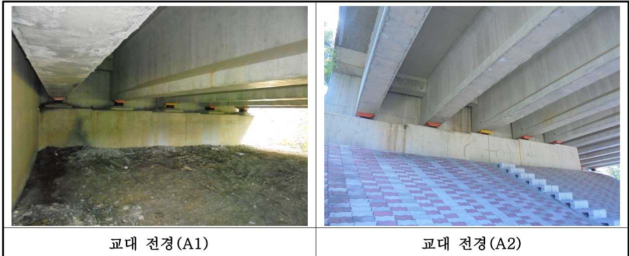
【사진 25.3.8】 교대 전경
