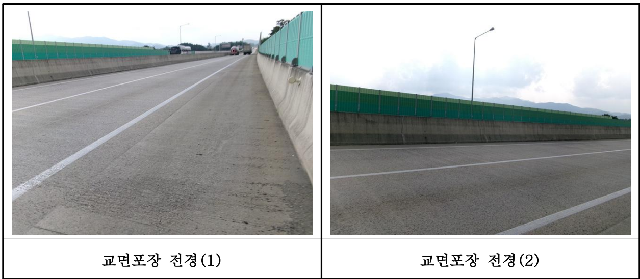
【사진 25.3.19】 교면포장 전경
