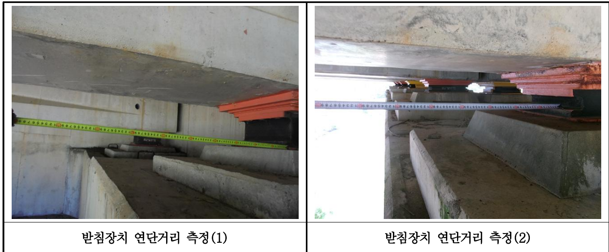
【사진 25.3.39】 교량받침장치 연단거리측정
