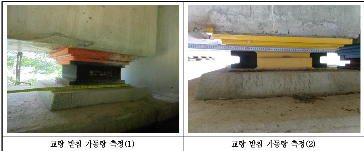
【사진 25.3.15】 교량받침 이동량 측정
