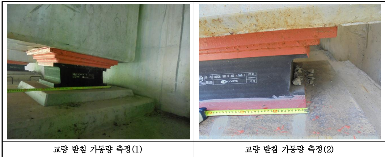
【사진 25.3.40】 교량받침 이동량 측정
