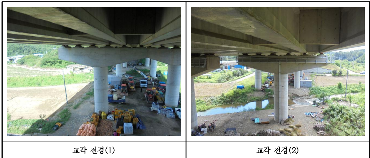
【사진 25.3.35】 교각 전경
