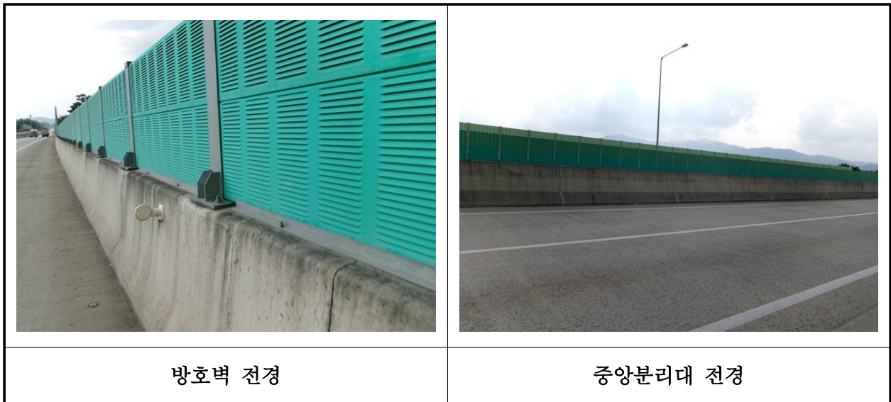
【사진 25.3.23】 방호벽 및 중양분리대 전경
