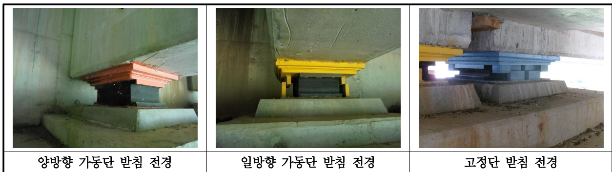
【사진 25.3.37】 교량받침 전경
