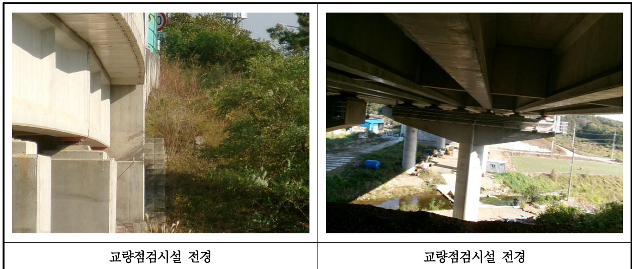
【사진 25.3.50】 교량 점검시설 전경
