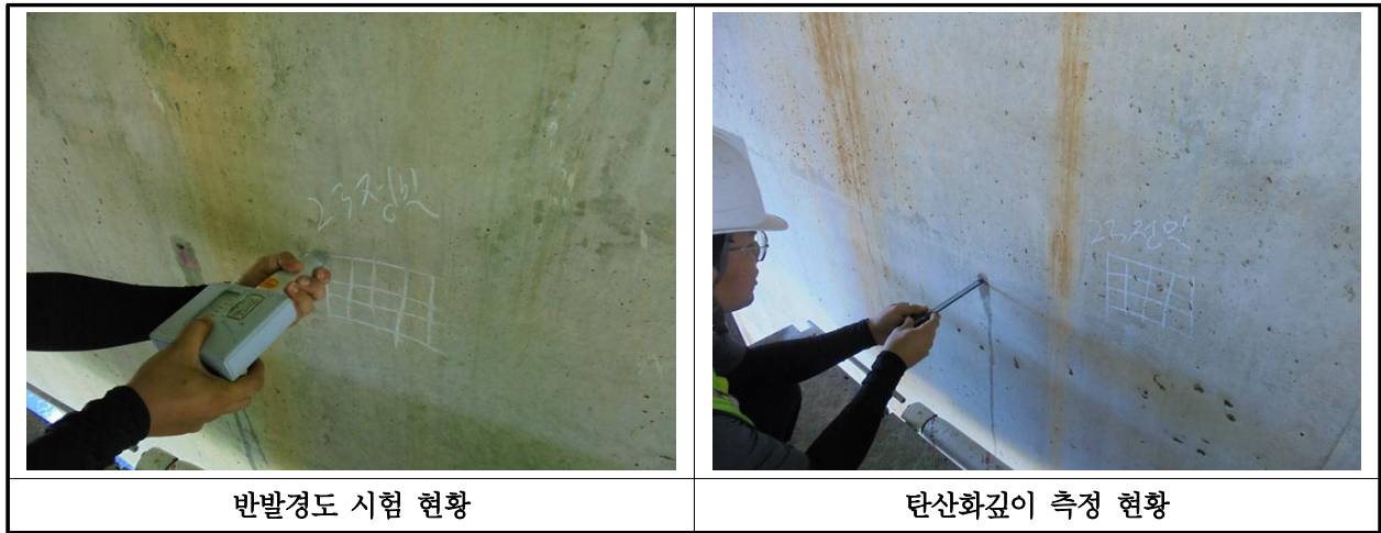
【사진 25.4.1】 콘크리트 내구성조사 현황
