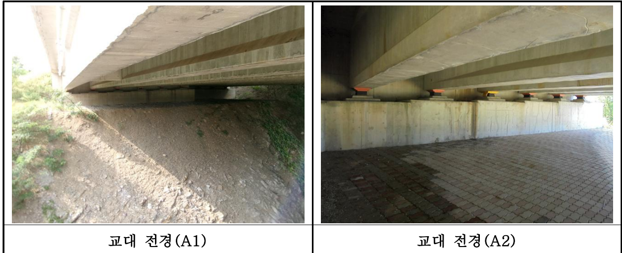
【사진 25.3.33】 교대 전경
