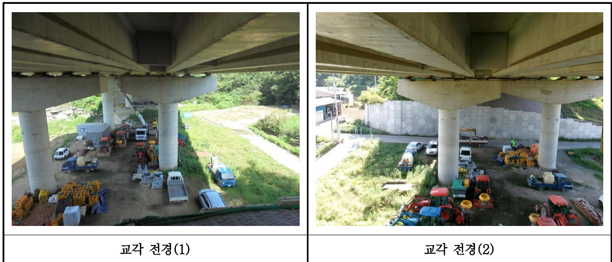
【사진 25.3.10】 교각 전경
