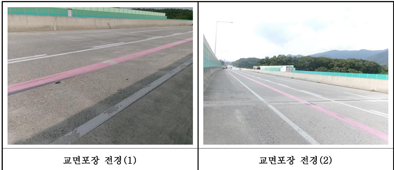
【사진 25.3.44】 교면포장 전경
