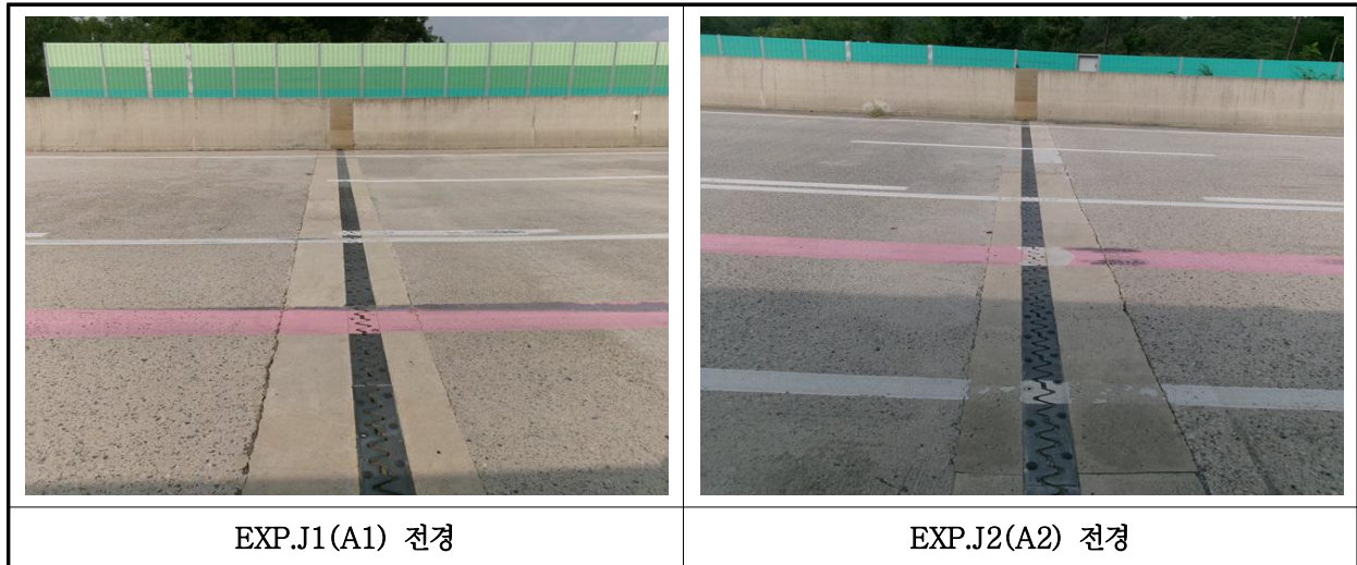
【사진 25.3.41】 신축이음장치 전경
